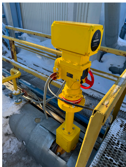
Рис. 1. Электропривод «РэмТЭК» на антипомпажном клапане Mokveld Valves
